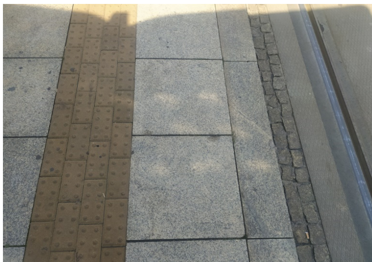
Fot. 4. Linia informująca o krawędzi skrajni
