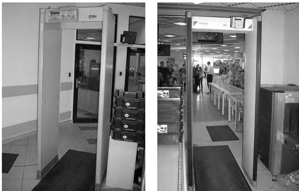
Rysunek 9. Bramki WTMD zainstalowane w MPL Katowice-Pyrzowice: z lewej Ceia, po prawej Rapiscan
